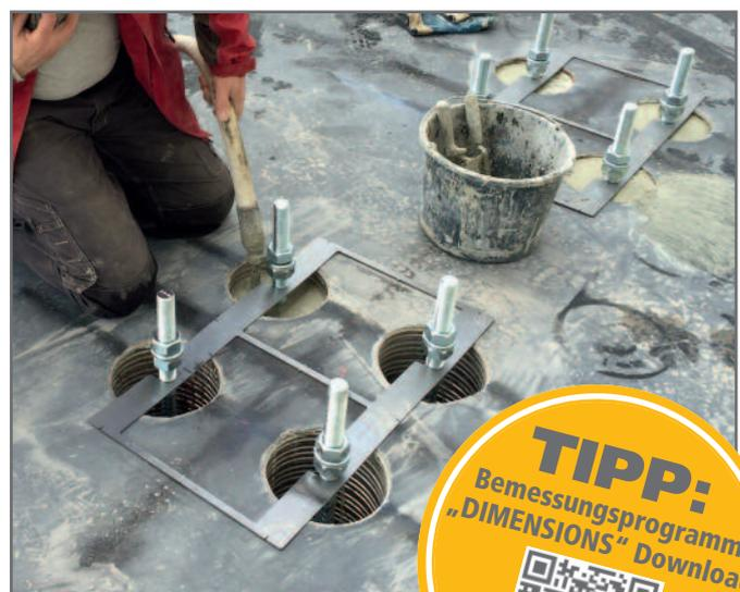
Verguss der Ankerstäbe mit Ankermörtel
