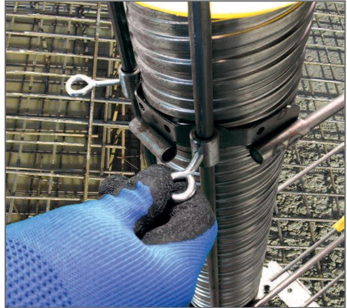
Fixieren des Verankerungs-Sets an den senkrechten Stäben des Montagerahmens nach dem Einstellen der korrekten Höhe.
