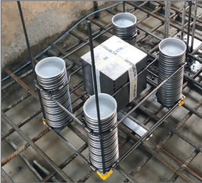
Befestigen des Montagerahmens an der unteren Bewehrungslage mit Draht
