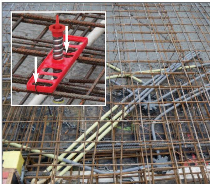
Die Gewindehülse mit Rödelfix wird einfach an die Bewehrung angerödelt. Anschließend kann die Höhe justiert werden. Bei Boden- bzw. Deckenplatten wird gefährliches Bohren vermieden, die Ankerpunkte können vor dem Betoniervorgang zielgenau und garantiert senkrecht eingepasst werden.
