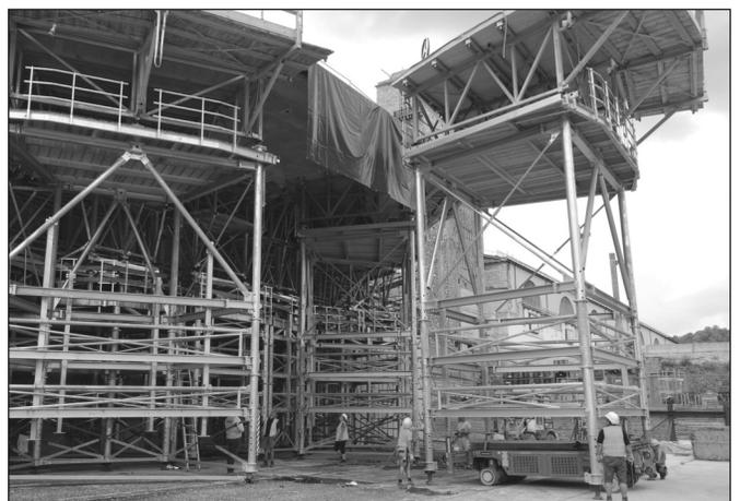
*BV S21 Stuttgart Tiefbahnhof: Sondertürme mit passendem Verfahrwagen für Schalungsabstützung*
