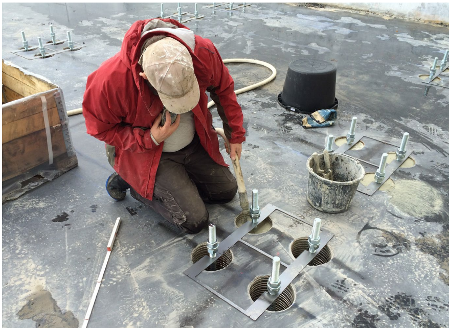
BU: Praxisgerechte Einbautoleranz der Ankerstäbe von bis zu 10 cm. – Quelle: ROBUSTA-GAUKE
