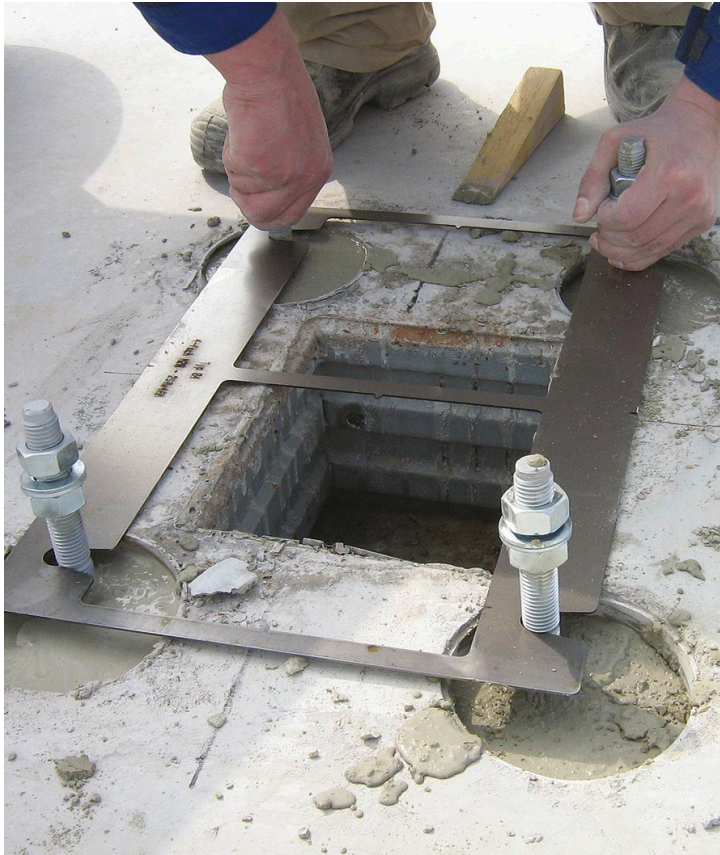
BU: Exakter Einbau mit dem passenden Schablonenblech und Verguss der Ankerstäbe mit Ankermörtel.- Quelle: ROBUSTA-GAUKE
