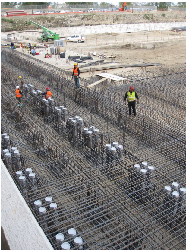
BU: Baustelle mit Verankerungssets im Einsatz. - Quelle: ROBUSTA-GAUKE
