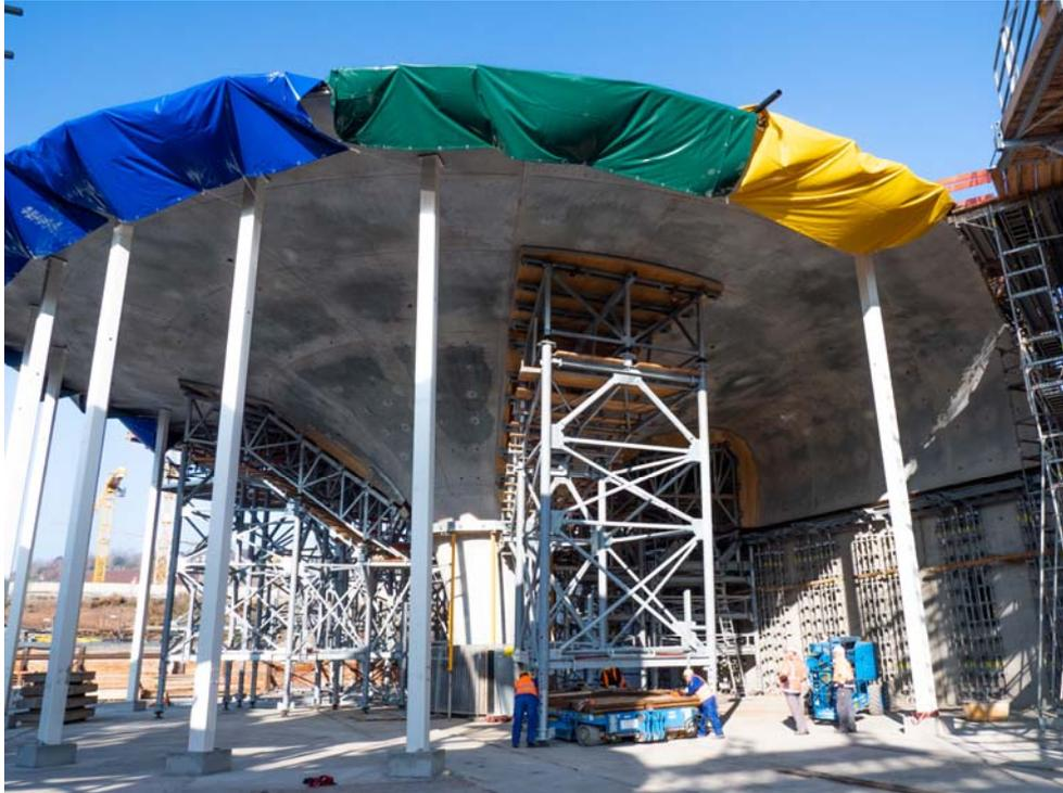
*BU: Ausschalarbeiten am ersten Randkehl: müheloses Umsetzen der tonnenschweren Rüsttürme mit dem Schwerlast-Plattformwagen. (Quelle: DB)*
