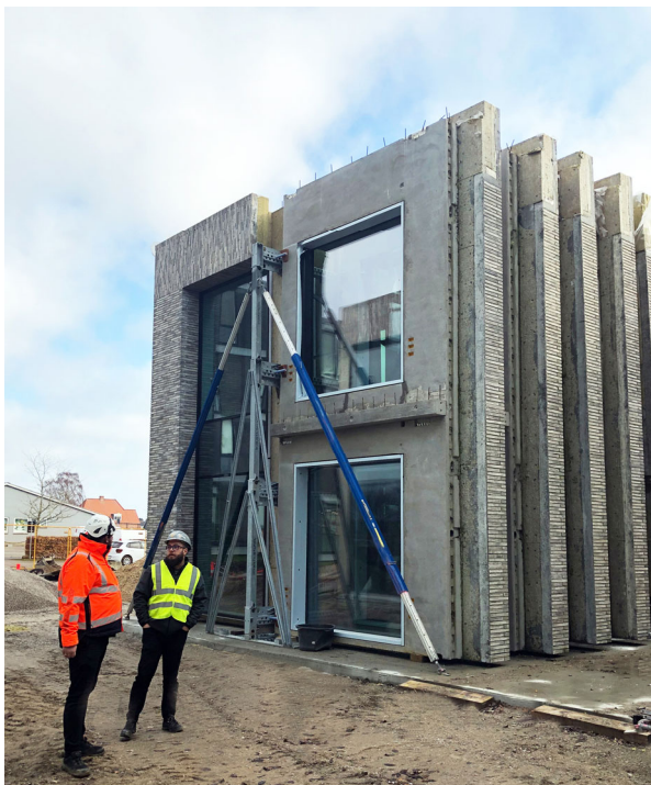
BU: Sicheres Zwischenlager für Fertigteil-Wandplatten im Fertigteilwerk und auf der Baustelle. © ROBUSTA-GAUKE
