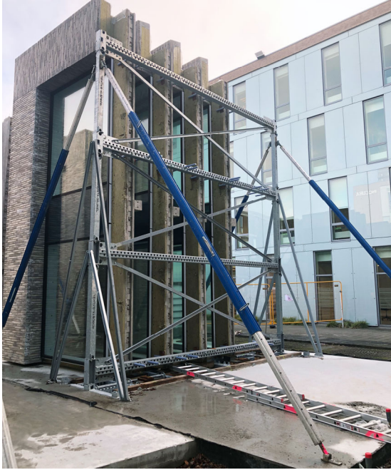
BU: Hohe, empfindliche Wandelemente sicher lagern mit dem DepoFlex Rechengestell © ROBUSTA-GAUKE
